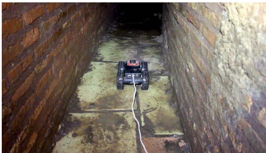
Figura 9 – Videoispezione preventiva per la valutazione del rischio con robot filoguidato
